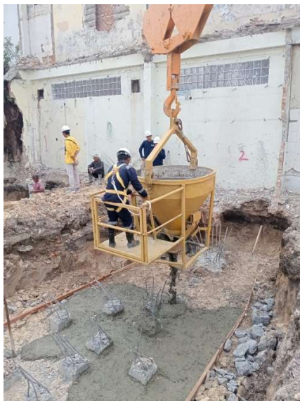
Pekerjaan Lantai Kerja
