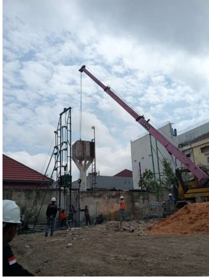
Pekerjaan Bored Pile
