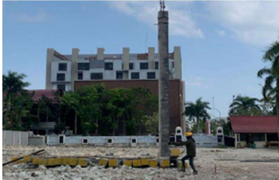
Gambar 2. 1 Pondasi Tiang Pancang
