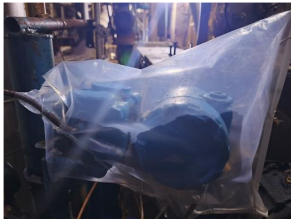
Gambar 3.9 After Pengantian cover PVC dan pembersihan housing Sumber: (Dokumentasi, 2026)
