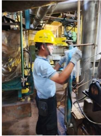
Gambar 3.8 Pengantian cover PVC Sumber: (Dokumentasi, 2026)
