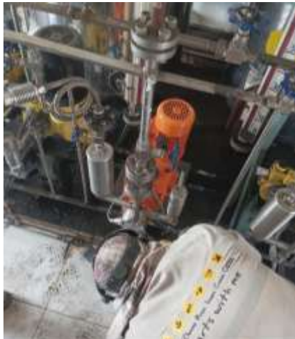
Gambar 3. 8 Proses Pemasangan (Sumber : Dokumentasi Penulis)
