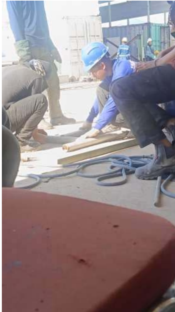
Gambar 3. 2 Pemantauan Area Kerja
