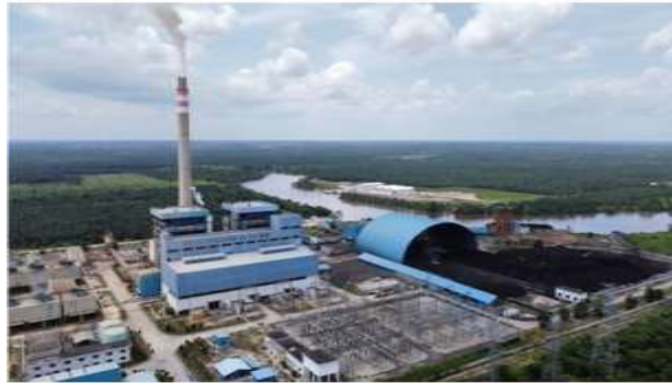
Gambar 1. 1 PLTU Tenayan awal bangun (Sumber: PT PLN Nusantara Power UP Tenayan, 2024)
