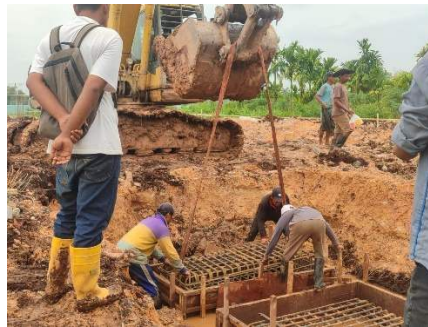
Gambar 3.28 Pemasangan Tulangan Tambahan dan Spiral
