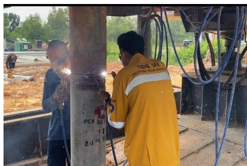
Gambar 3.13 Penyambungan Tiang
