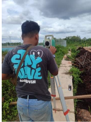
Gambar 3.18 Pengukuran Menggunakan Theodolit
