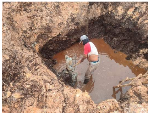
Gambar 3.26 Pembobokan Kepala Tiang
