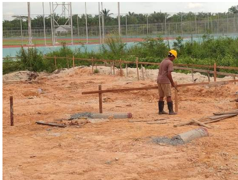
Gambar 3.20 Pemasangan Papan Bowplank
