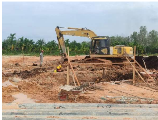
Gambar 3.24 Pembuangan atau Penataan Tanah Galian
