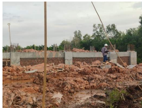
Gambar 3.40 Pondasi Rollag
