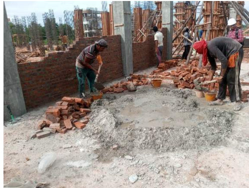
Gambar 3.47 Pemasangan Dinding
