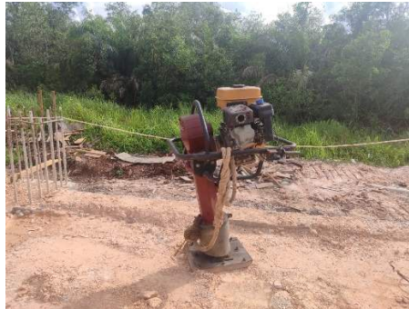
Gambar 3.41 Pemadatan Tanah
