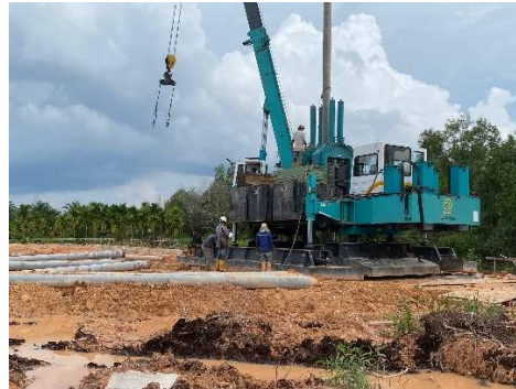
Gambar 3.8 Pemancangan Tiang Pancang (HSPD)
