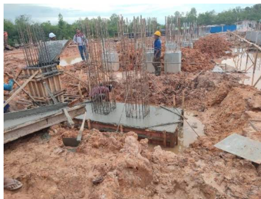
Gambar 3.31 Pondasi P1A
