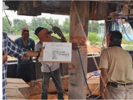
Gambar 3.11 Proses Pemancangan
