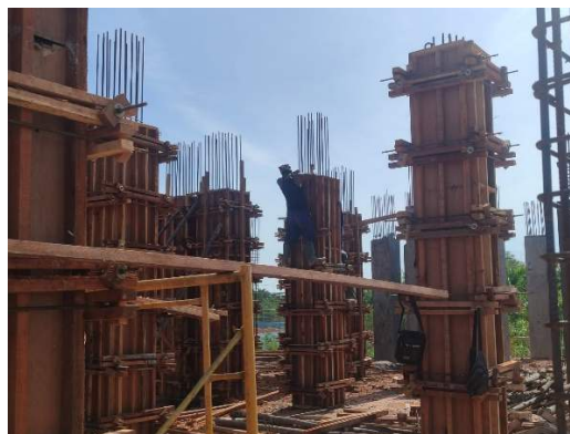
Gambar 3.44 Kolom K1 Sumber: Dokumentasi lapangan 2025
