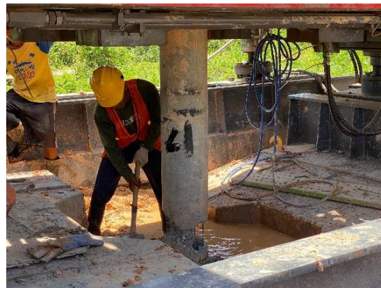
Gambar 3.15 Pemotongan Kepala Tiang
