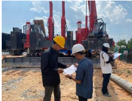
Gambar 3.14 Pencatatan Data Pemancangan
