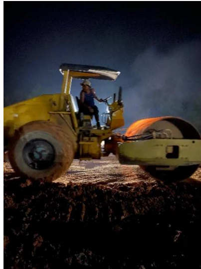
Gambar 2.17 Vibro Roller
