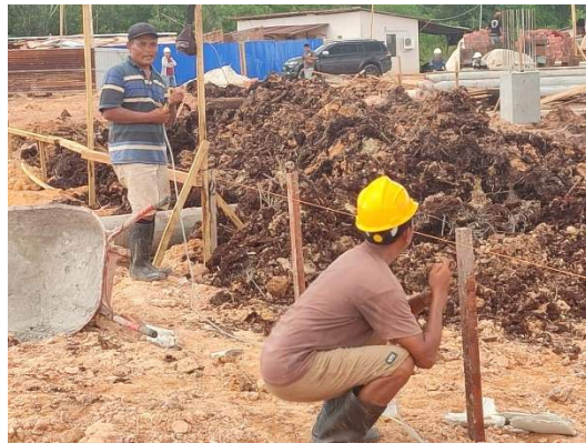
Gambar 3.19 Pemasangan Patok
