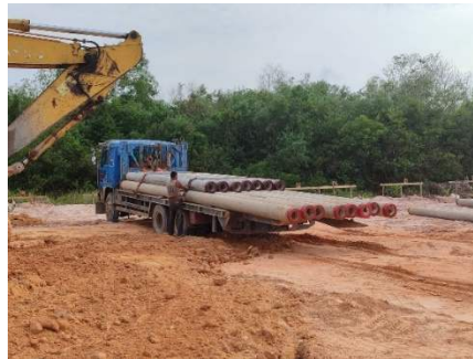
Gambar 3.10 Mobilisasi dan Penempatan Tiang Pancang
