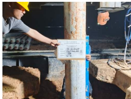
Gambar 3.12 Pengendalian Vertikalitas dan Elevasi
