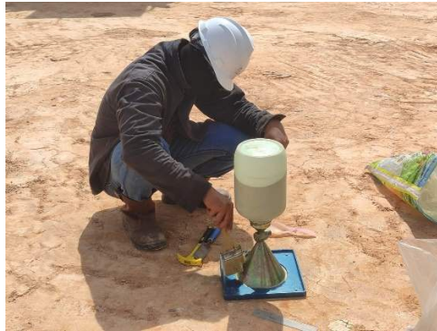
Gambar 3.6 Pengujian Kepadatan ( Sand Cone Test )
