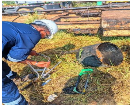
Gambar 2. 9 kabel Reda ke switchboard Sumber : (Dokumentasi)
