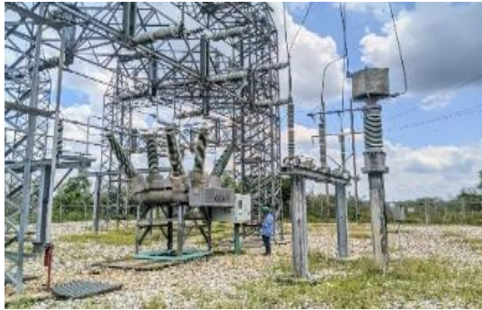
Gambar 2. 3 control room substation Sumber : (Dokumentasi)
