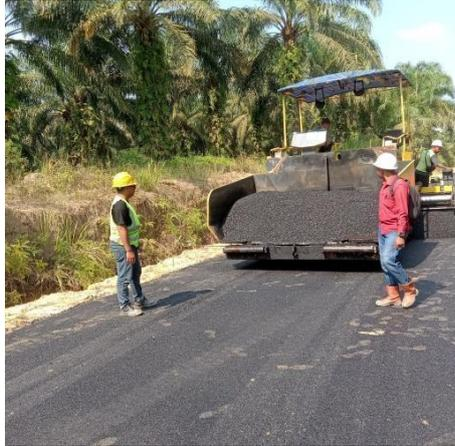
*GAMBAR 4 3 Penghamparan lapisan AC-WC menggunakan Asphalt finisher Sumber : Dokumentasi lapangan, 2024*
