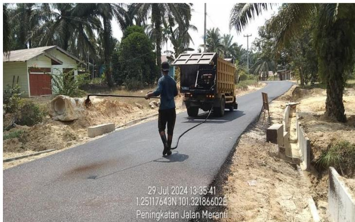
*GAMBAR 3 2 asphalt sprayer*
