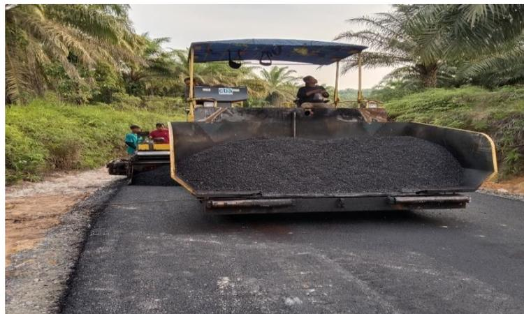
*GAMBAR 3 5 asphalt pinisher*
