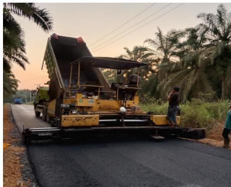
GAMBAR 4 2 Penuangan lapisan AC-WC kebak mekanis
