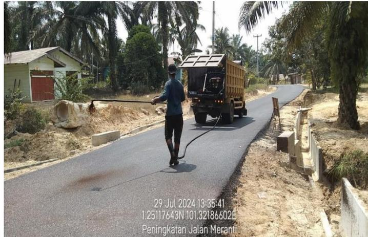
*GAMBAR 3 7 Pekerjaan Prime Coat*
