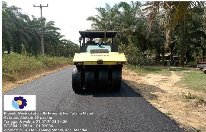
*GAMBAR 3 10 Pekerjaan Pematatan Akhir Aspal AC-WC Menggunakan Pneumatic Tire*
