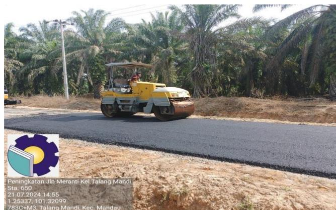
*GAMBAR 3 9 Pekerjaan Pemadatan Awal AC-WC Menggunakan Tandem Roller*
