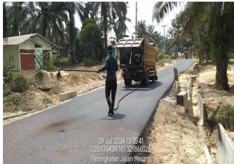
GAMBAR 4 1 Pekerjaan Prime Coat Sumbe
