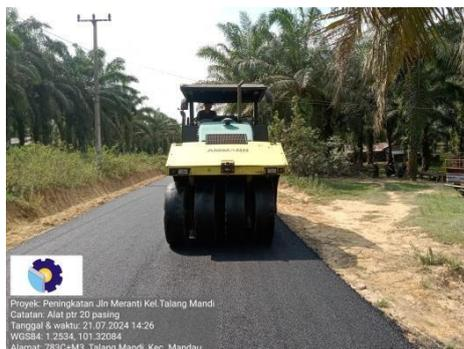
*GAMBAR 4 7 Pekerjaan Pematatan Akhir Aspal AC-WC Menggunakan Pneumatic Tire Roller*
