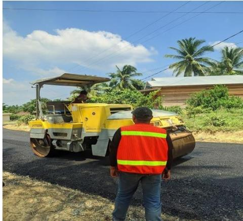
*GAMBAR 4 6 Pekerjaan Pematatan Awal AC-WC Menggunakan Tandem Roller*
