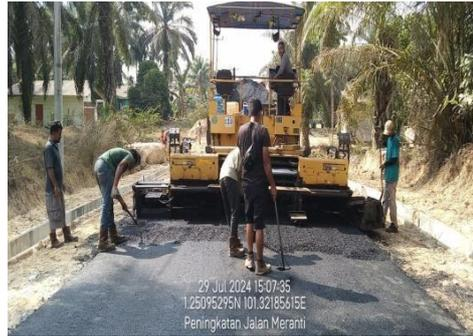
*GAMBAR 4 5 Pemerataan lapisan AC-WC menggunakan cheker*
