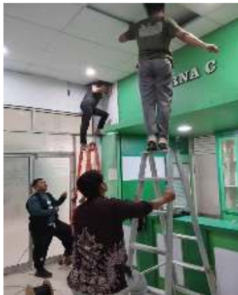
Gambar 3.7 Pemasangan kabel UTP
