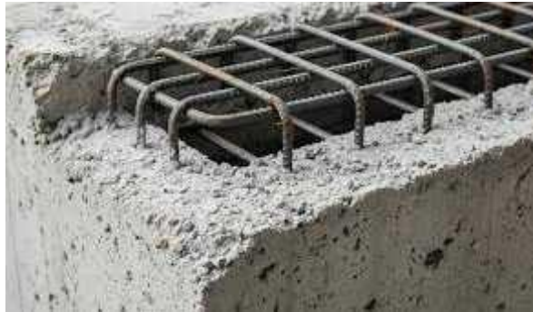
Gambar 2. 5. Beton Bertulang (Sumber : Google Earth)
