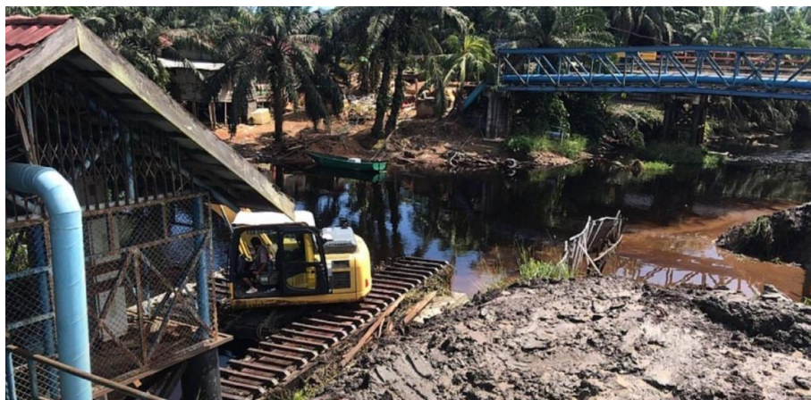
Gambar 1. 2 Pengerukan Yang Dilakukan Menggunakan Exavator Darat
