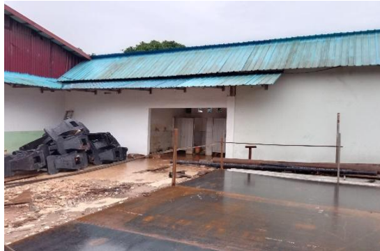
Gambar 2. 12 Toilet dan Tempat Wudhu Sumber: PT LOI, (2025)
