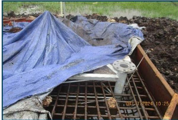
Gambar 3. 9 Pemasangan bekisting
