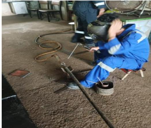
Gambar 3. 2 Pengelasan Pipa D3 inchi dengan elektroda 8018
