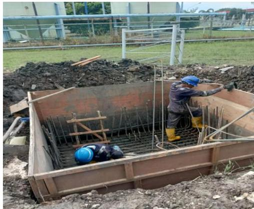
Gambar 3. 8 Proses pemasangan rebar dan segmen 13
