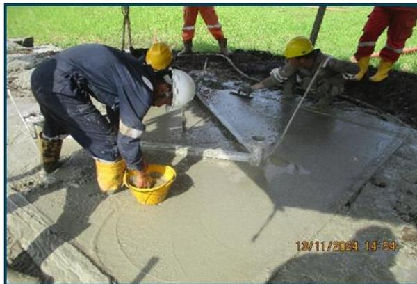
Gambar 3. 10 Pengecoran dan perataan menggunakan vibrator
