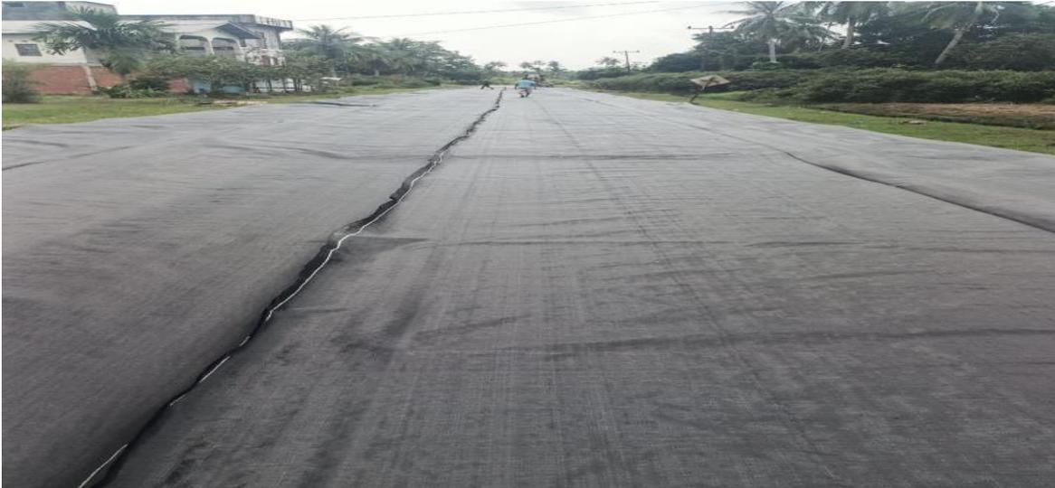
GAMBAR 3.1.2 Pemasangan Geotextile
